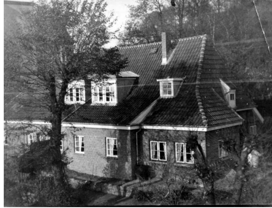
Hausansicht von Süden
