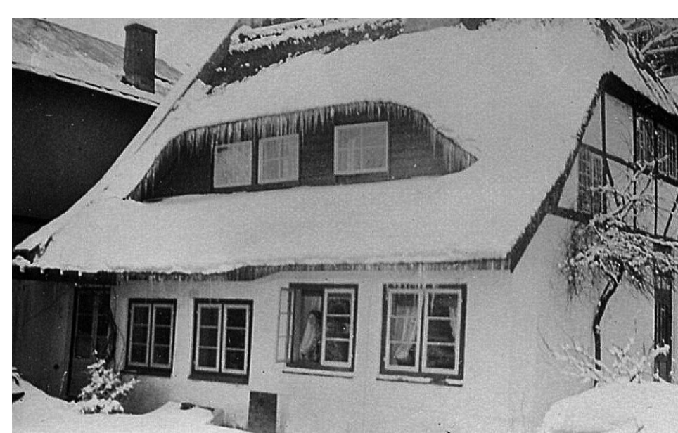
Hausansicht von Süden
