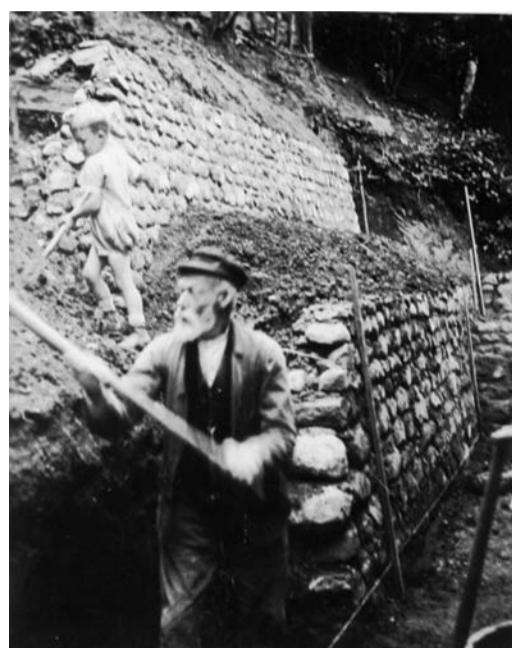
1927 wurde das Bollwerk repariert
